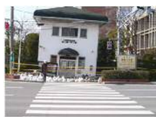
地盤の液状化による被害例
