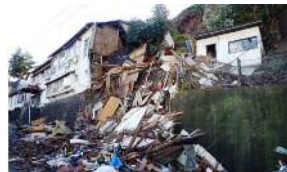
斜面崩壊による被害例
