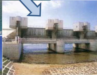
津波対策として 設置された青苗川水門
